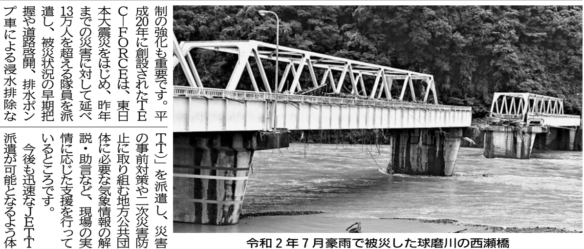
令和2年7月豪雨で被災した球磨川の西瀬橋
